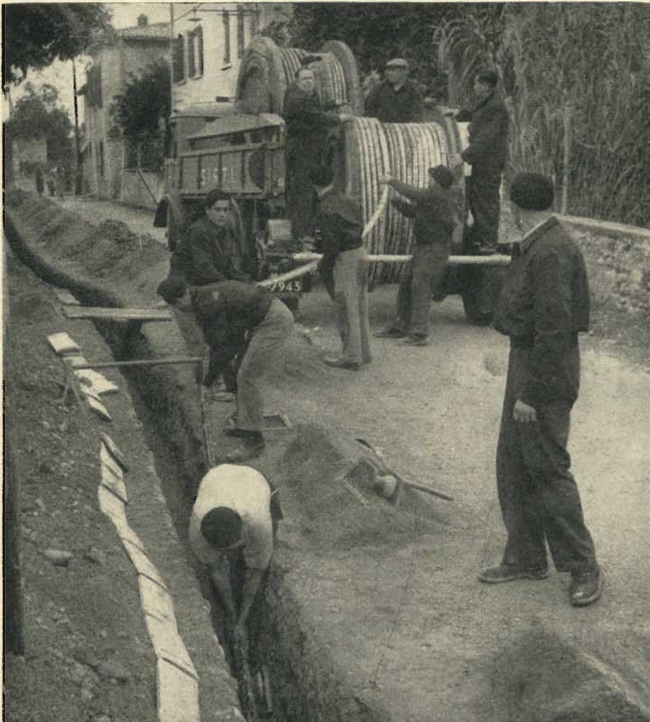
La S.I.R.T.I. inizia la posa della prima bobina di cavo coassiale della nuova rete telefonica italiana.
